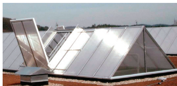
System klapy pojedynczej VARIO-FIREJET® 65° (EKS) do EKS-TH z kątem otwarcia 65°, zabudowany w pasmie świetlnym dwuspadowym VARIO-THERM-S
