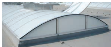
VARIO-NORM sávos felülvilágító VARIO-FIREJET® 130 J hő- és füstelvezető nyílászárny rendszerrel
